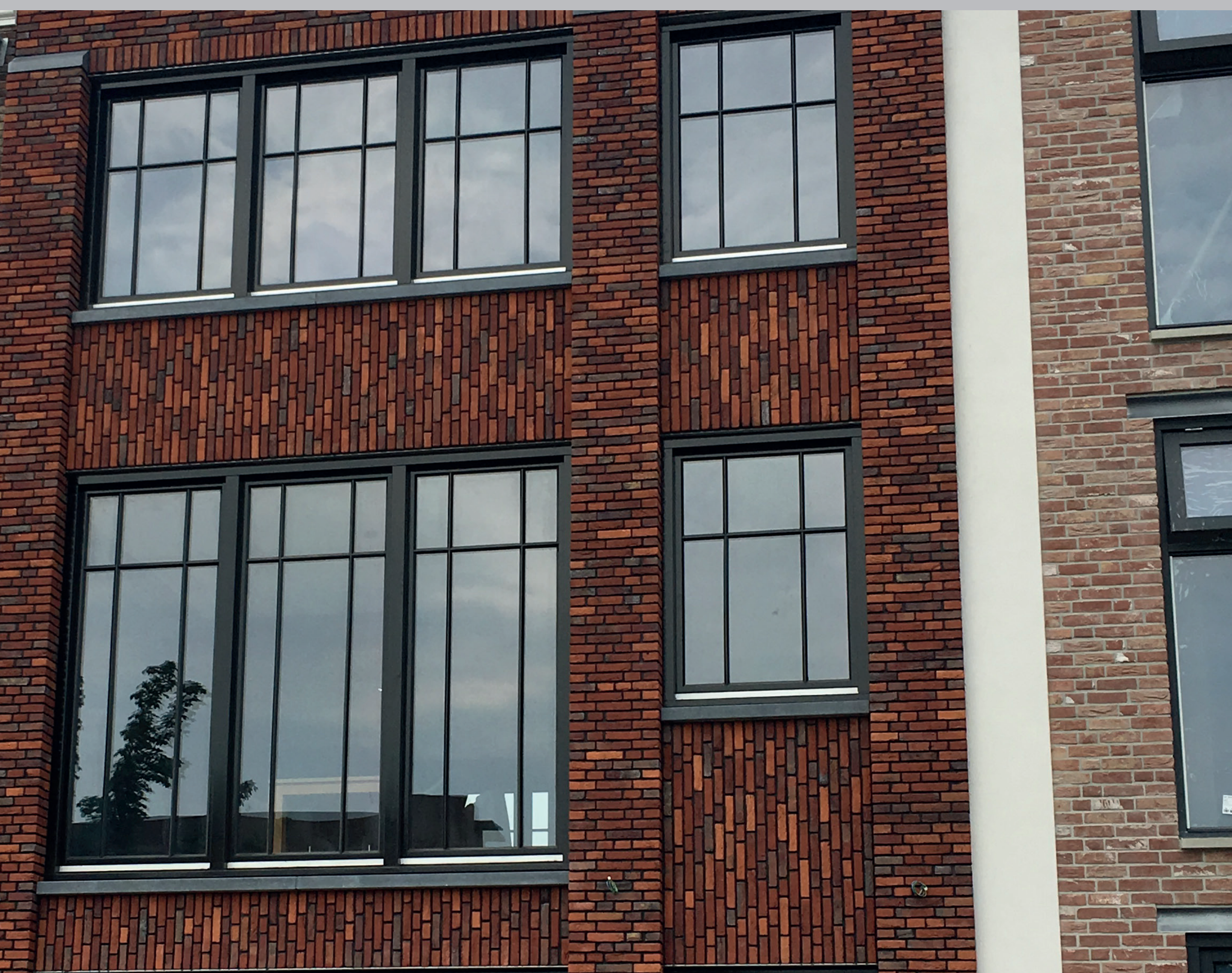
Terugliggend staand metselwerk (referentiebeeld)
