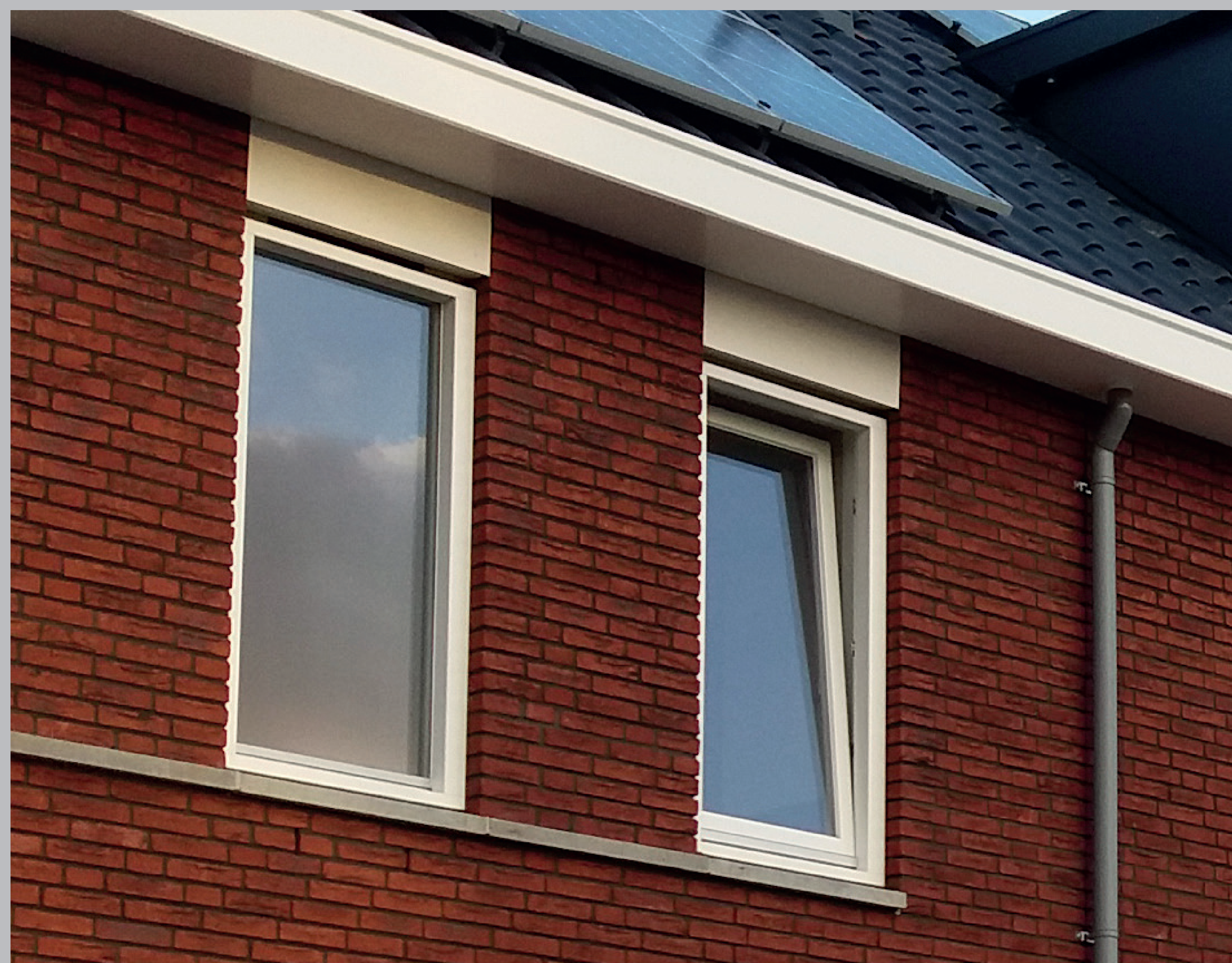
Betonnen spekband (referentiebeeld)
