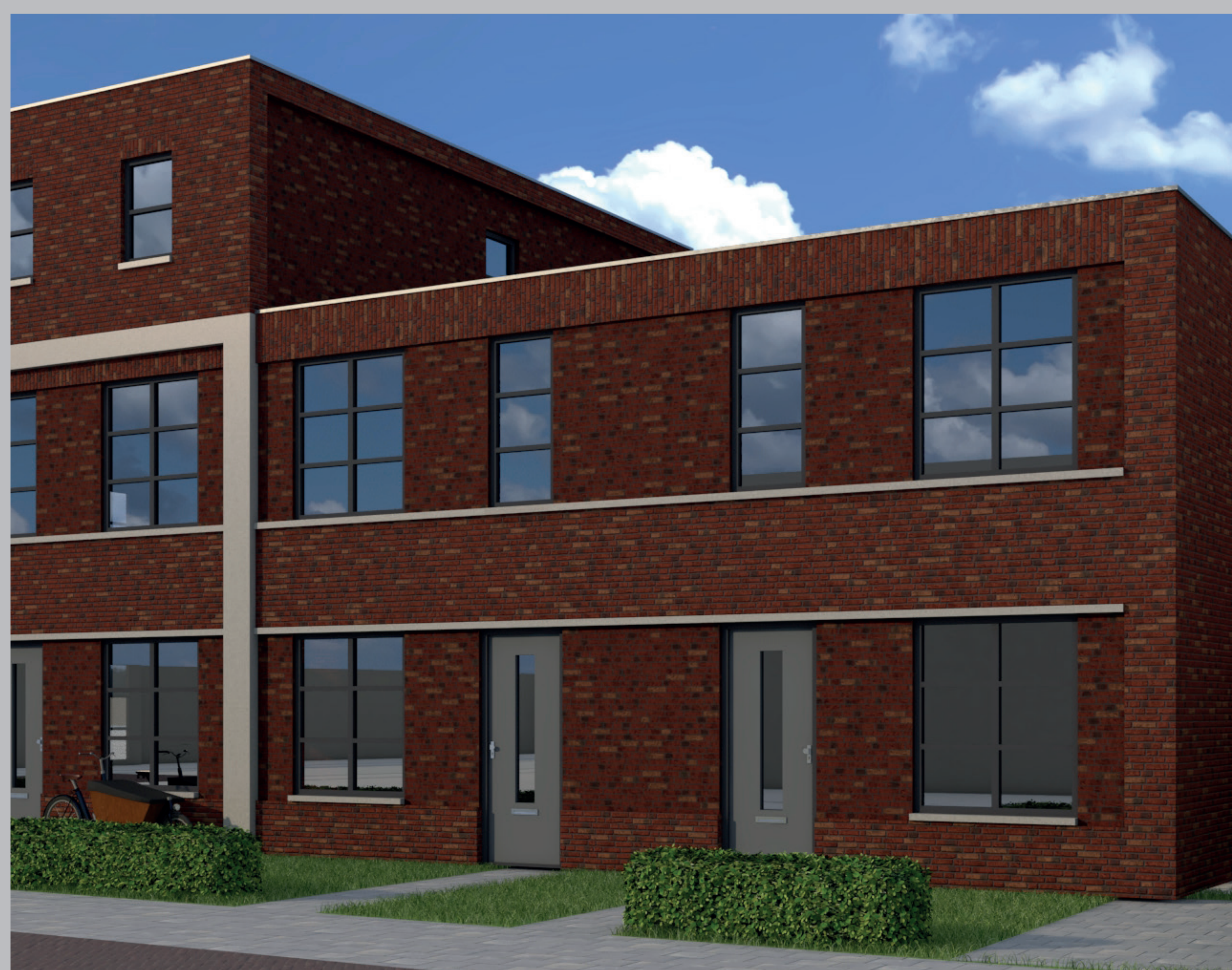
Horizontale geleding met spekbanden en metselwerkverbanden
